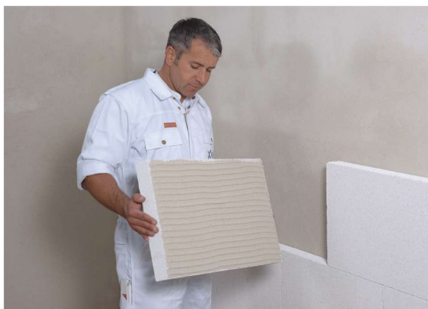
Slika 5: Toplotna izolacija zidova ka negrijanom prostoru
