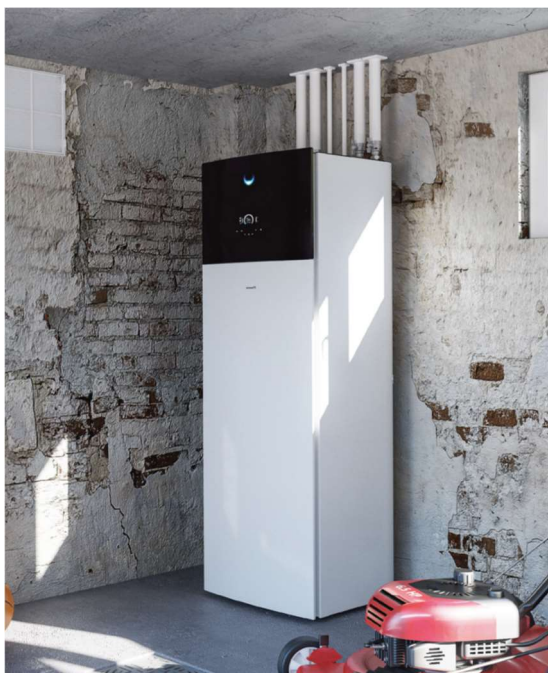
Slika 18: Izgled unutrašnje jedinice visokotemperaturne toplotne pumpe povezane na sistem centralnog radijatorskog grijanja instalisane u garažnom prostoru
