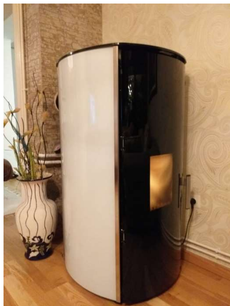
Slika 15: Izgled peći na pelet za centralno grijanje povezana sa radijatorima kao grejnim tijelima - u stanu u stambenoj zgradi
