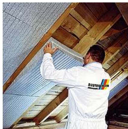
Slika 8: Postavljanje toplotne izolacije pločama od EPS-a na kosom krovu sa unutrašnje strane
