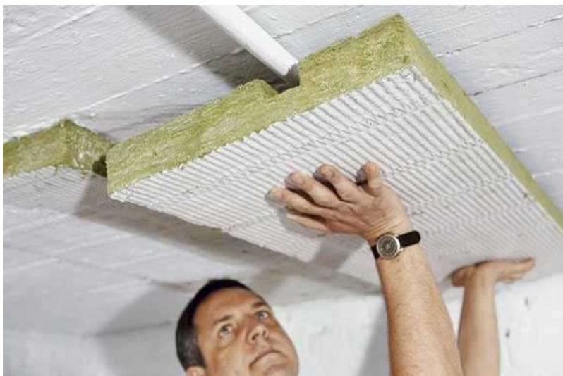
Slika 9: Toplotna izolacija međuspratne konstrukcije ka negrijanom podrumu
